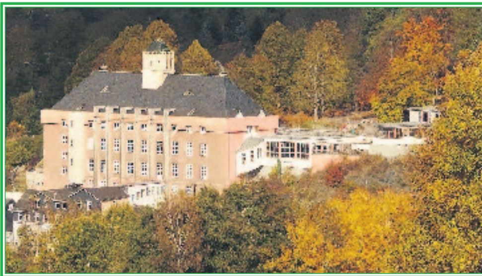
Eines der bedeutendsten Bauhaus-Denkmäler in Thüringen: Stolz präsentiert sich das Haus des Volkes heute wieder als ein Wahrzeichen über den Dächern von Probstzella Foto: Dieter Nagel
