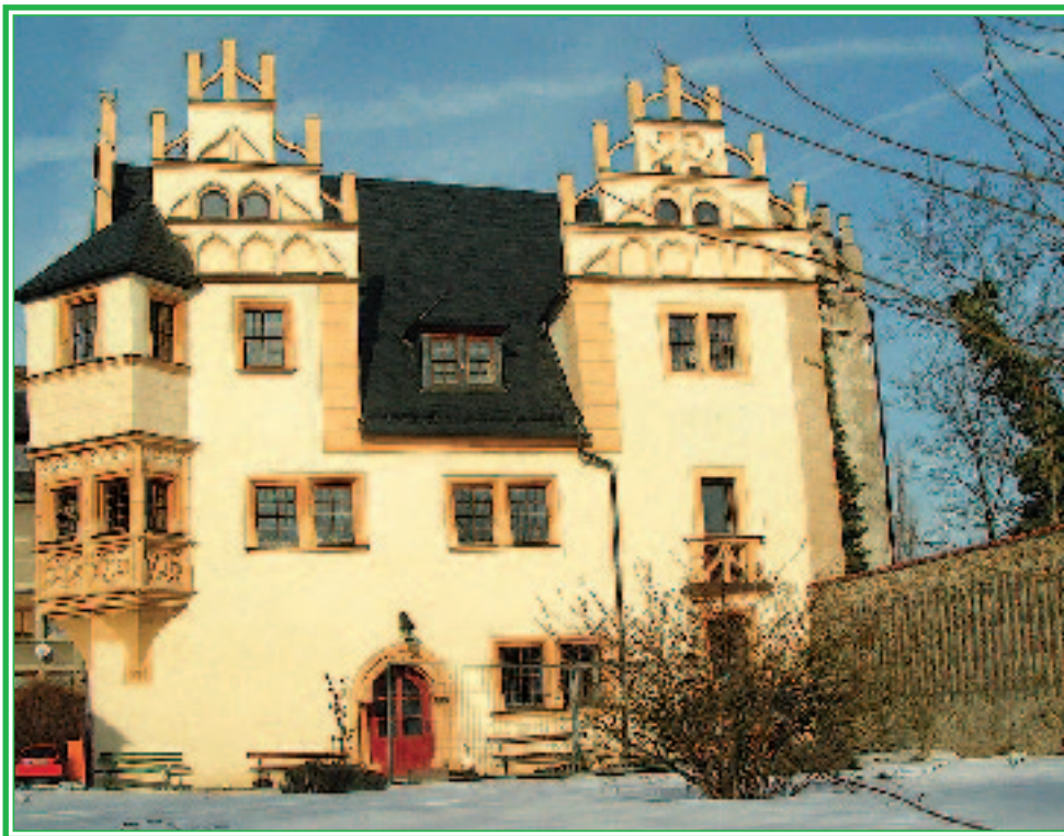
Blick auf die restaurierte Südfassade des Schlösschens Kitzerstein. Mit den neuen Toilettenanlagen wurde 2005 ein weiterer Schritt der Sanierung der Kreismusikschule abgeschlossen. Foto: Isabell Krauß
