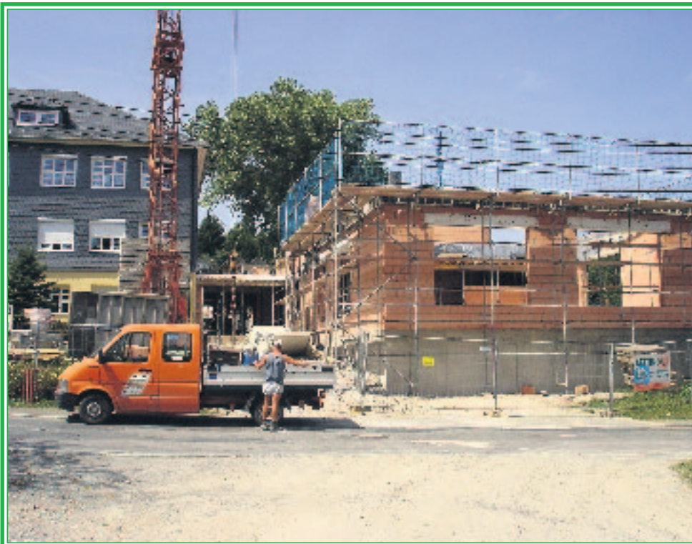
Trotz der hochsommerlichen Temperaturen schreitet die Arbeit am Erweiterungsneubau der Regelschule Oberweißbach gut voran.
