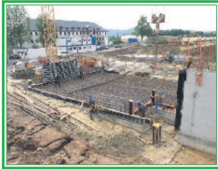
Blick auf die Baustelle im Juli
