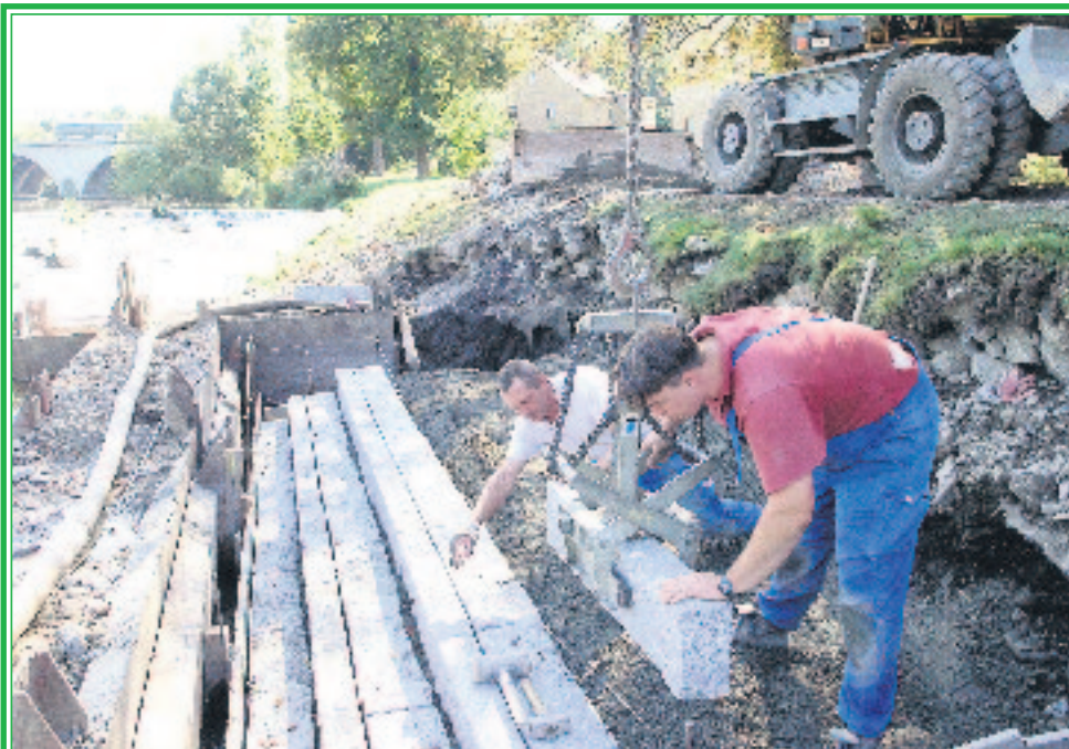
Wasserwandern an der Saale: René Riedel (rechts) und Peter Rüdiger von der Strabag in Pößneck setzen einen Granitstein für eine Treppe zum Einsetzen der Boote unterhalb des Wehrs an der Saalebrücke in Saalfeld. Rund 257 000 Euro werden an 18 Baustellen im Landkreis investiert, um die Saale für Wasserwanderer attraktiver zu machen. Bis Ende Oktober sollen die Baumaßnahmen fertig sein. Foto: Lahann
