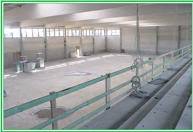
Rohbau der neuen 3-Felder-Halle
