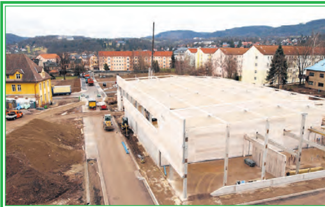
Ein Vierteljahr später werden die Seitenteile montiert.
