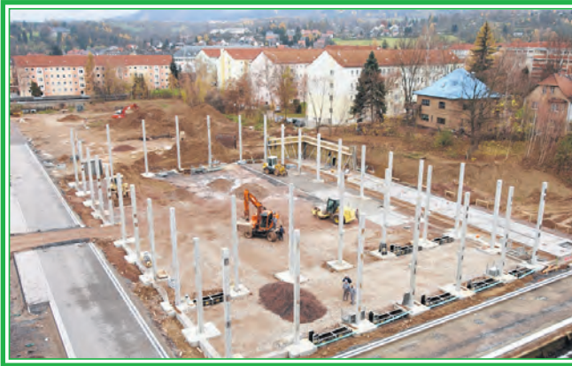
Anfang November 2007 stehen die Stützpfiler.
