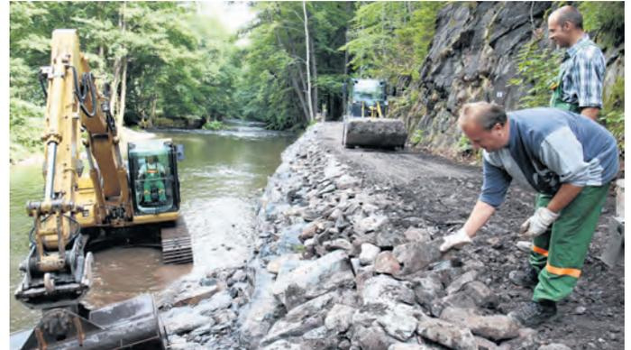
**Schwarzburg/Sitzendorf (AB/mo).** Die Arbeiten am zweiten Bauabschnitt des Schwarzatalradweges laufen. In der vergangenen Woche bauten Polier Michael Braun, Olaf Zoladz und Ralf Müller (im Bild von rechts) von der Lichter Firma Wächter Bau unter Einsatz schweren Gerätes an einer Stützmauer zur Verbreiterung des Radweges weiter. Ende September ist es soweit: Dann ist der Schwarzatalradweg auf der Gesamtstrecke von Bad Blankenburg nach Sitzendorf befahrbar. In den
