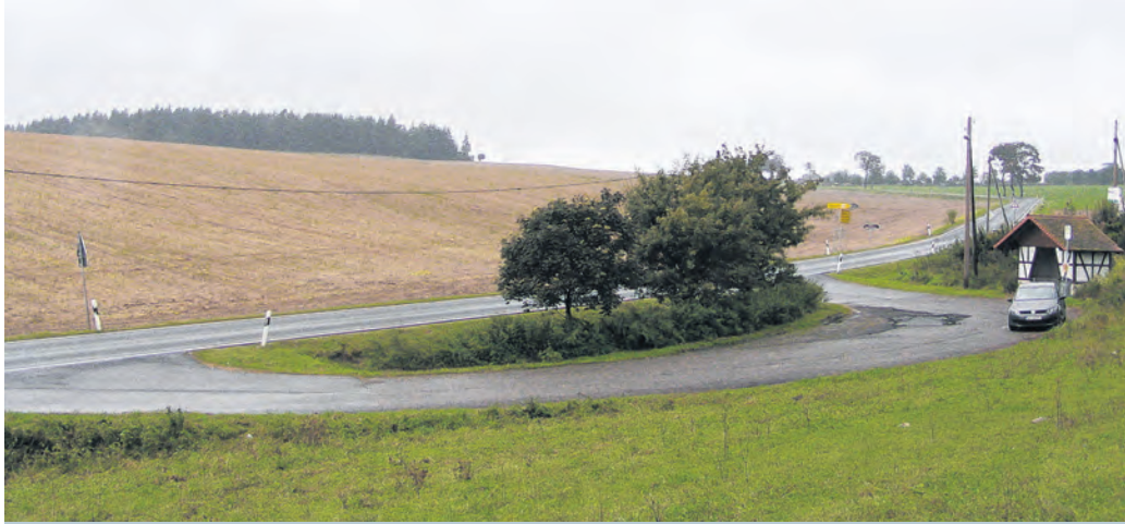
Das Straßenstück bei Groschwitz soll in diesem Jahr ausgebaut werden.
