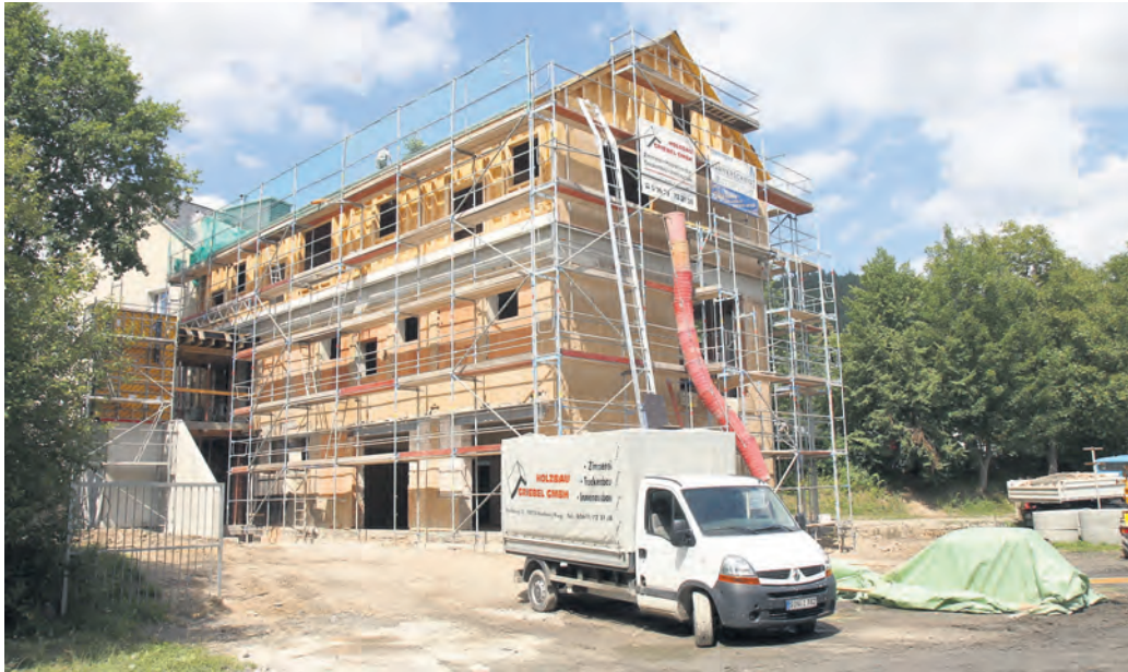
Wie hier am Schul- und Kindergartenstandort in Leutenberg wird in den Sommerferien an vielen Schulen des Landkreises gebaut. Am 5. August fällt der Startschuss für die Zweifelhalle in Rudolstadt. Foto: pl
