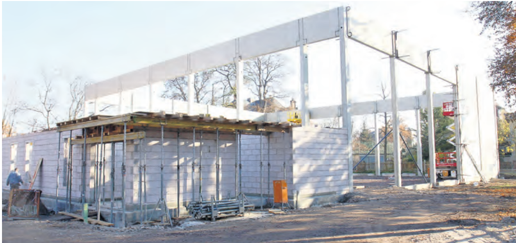
Am Gymnasium Fridericianum nimmt die neue Zweifeldsporthalle immer mehr Gestalt an. Nach dem ersten Spatenstich am 5. August sind bereits der Hallenkörper und die Funktionsräume (vorn) erkennbar. Bis zum Beginn des nächsten Schuljahres soll die Halle fertig sein. Foto: Lahann
